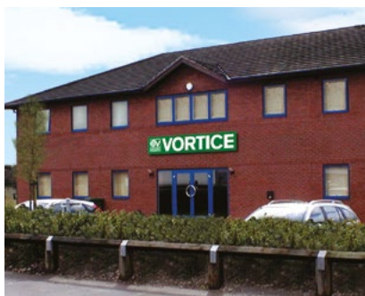
La sede di Vortice Limited, a Burton on Trent nel East Midlands, è operativa dal 1977.
